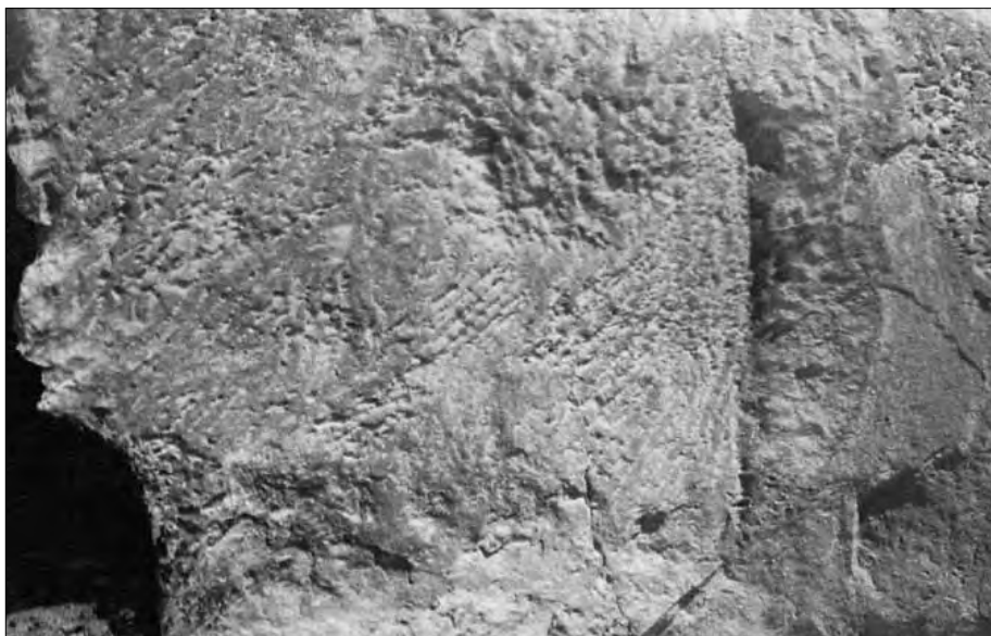
Ein Ausbruch eines Segmentes, wo der Trennschneider nicht in der Ebene blieb. (Nieper)
