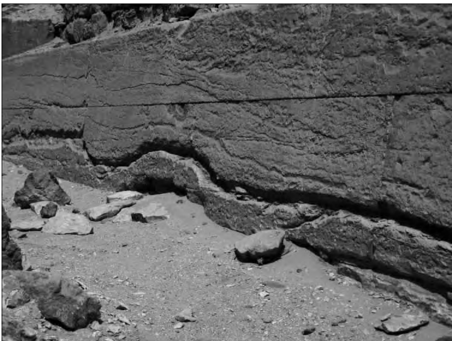
Block- und fugenübergreifende Steinstrukturen bezeugen, dass die Steinblöcke so, wie sie im Steinbruch geschnitten wurden, hier wieder zusammengesetzt wurden, unten sogar über mehrere Lagen hinweg (Mastabafeld westlich der Cheopspyramide).
