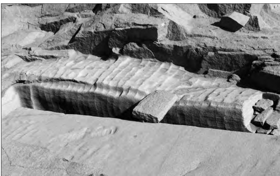
Die Granitsteinbearbeitung im Assuan-Steinbruch sieht mir nicht so aus, als ob sie mit Steinhämmern ausgeführt worden wären. Granit ist ein überaus hartes, sprödes Gestein, das wegen seiner Härte bei einer Bearbeitung schnell wegplatzt. Betrachtet man sich den bearbeiteten Granit, so hat man den Eindruck, als ob hier mit einer Art Löffel das weiche Gestein weggekratzt wäre. Aber wie soll Granit weich gemacht werden?
