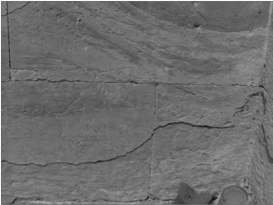
Block- und fugenübergreifende Steinstrukturen bezeugen, dass die Steinblöcke so, wie sie im Steinbruch geschnitten wurden, hier wieder zusammengesetzt wurden, unten sogar über mehrere Lagen hinweg (Mastabafeld westlich der Cheopspyramide).
